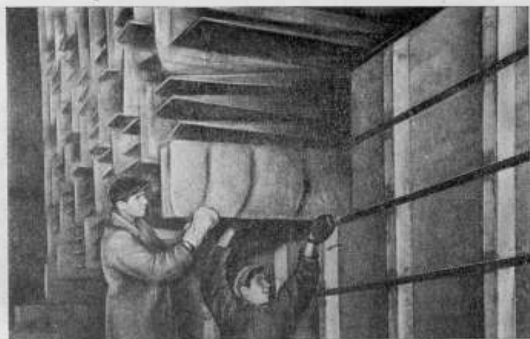
Рис. 5. Монтаж блоков в камере на каркасе
