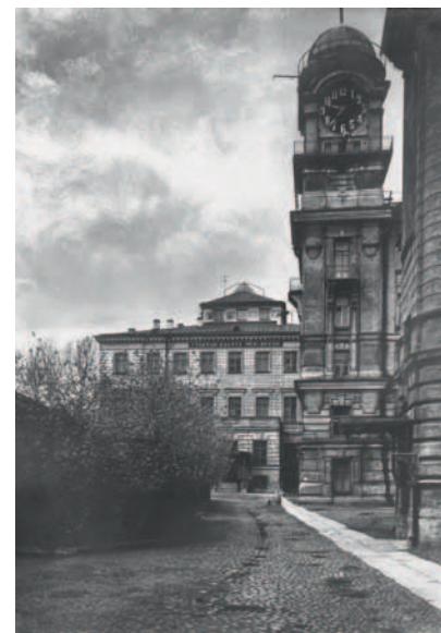
Центральное здание Главной палаты мер и весов (1879 г., арх. Ф. Ф. Бекман) и «Здание с башней» (1902 г., арх. С. С. Козлов). Фото 1920-х гг.
